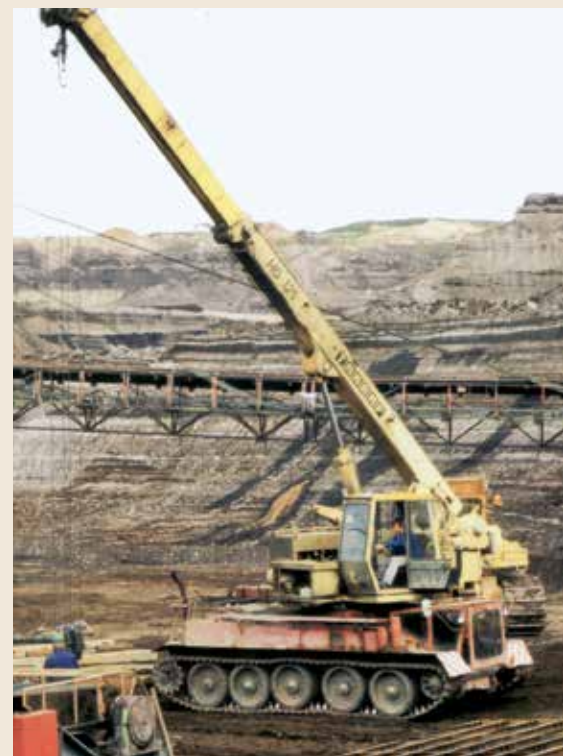
Austeleskopiert erreichte der Ausleger 11,46 m Länge, mit einem zusätzlichen Ausschub waren sogar 15,06 m möglich; die Kabine für den Kranführer stammte von einem DDR-Bagger.
