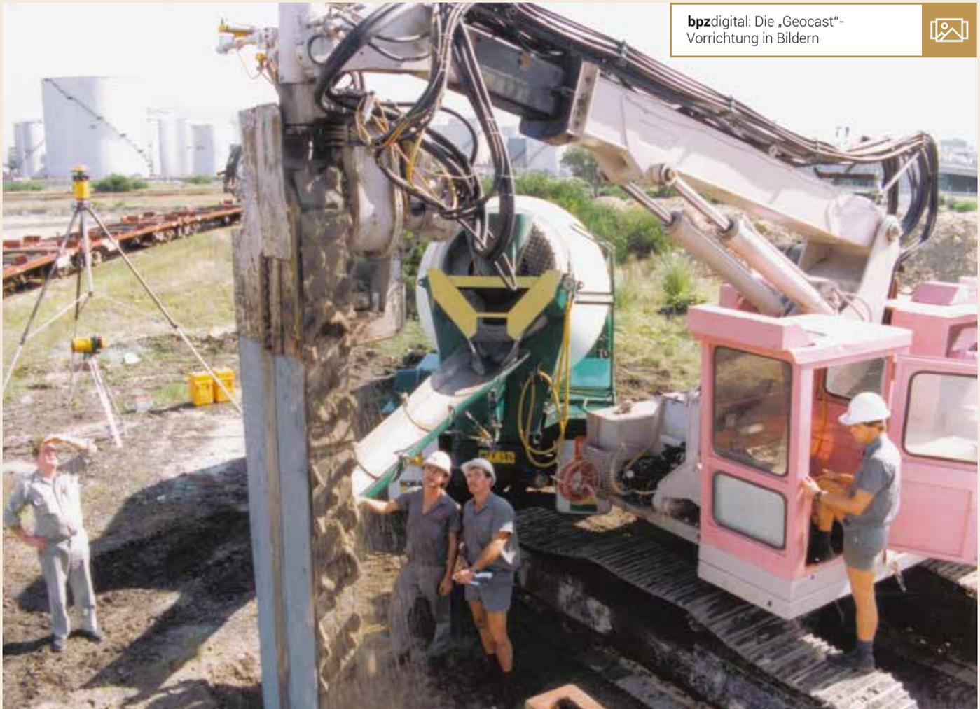
Im Vordergrund die „Geocast“-Vorrichtung mit Trägermaschine und Fräskette am teleskopierbaren Ausleger, dahinter der bereitstehende Betonmischer für die Wandherstellung.
