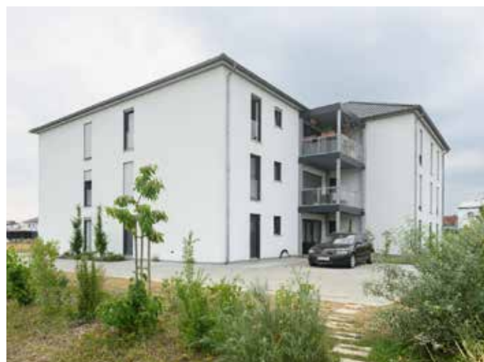
Das in Ziegelbauweise errichtete Mehrfamilienhaus überzeugt durch durchgehend hohen Brand-, Wärme- und Schallschutz.
